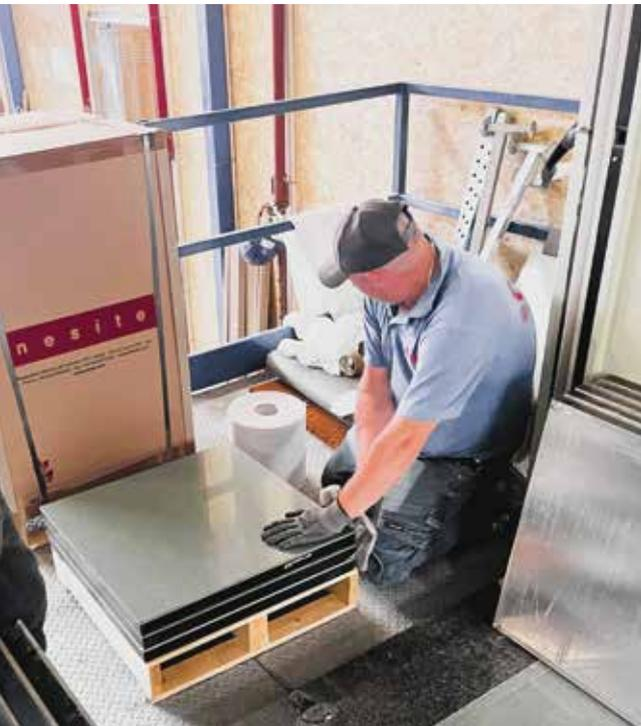
*Fig. 2 Operazione di selezione e reimballaggio dei pannelli recuperati dal sito di dismissione.*
