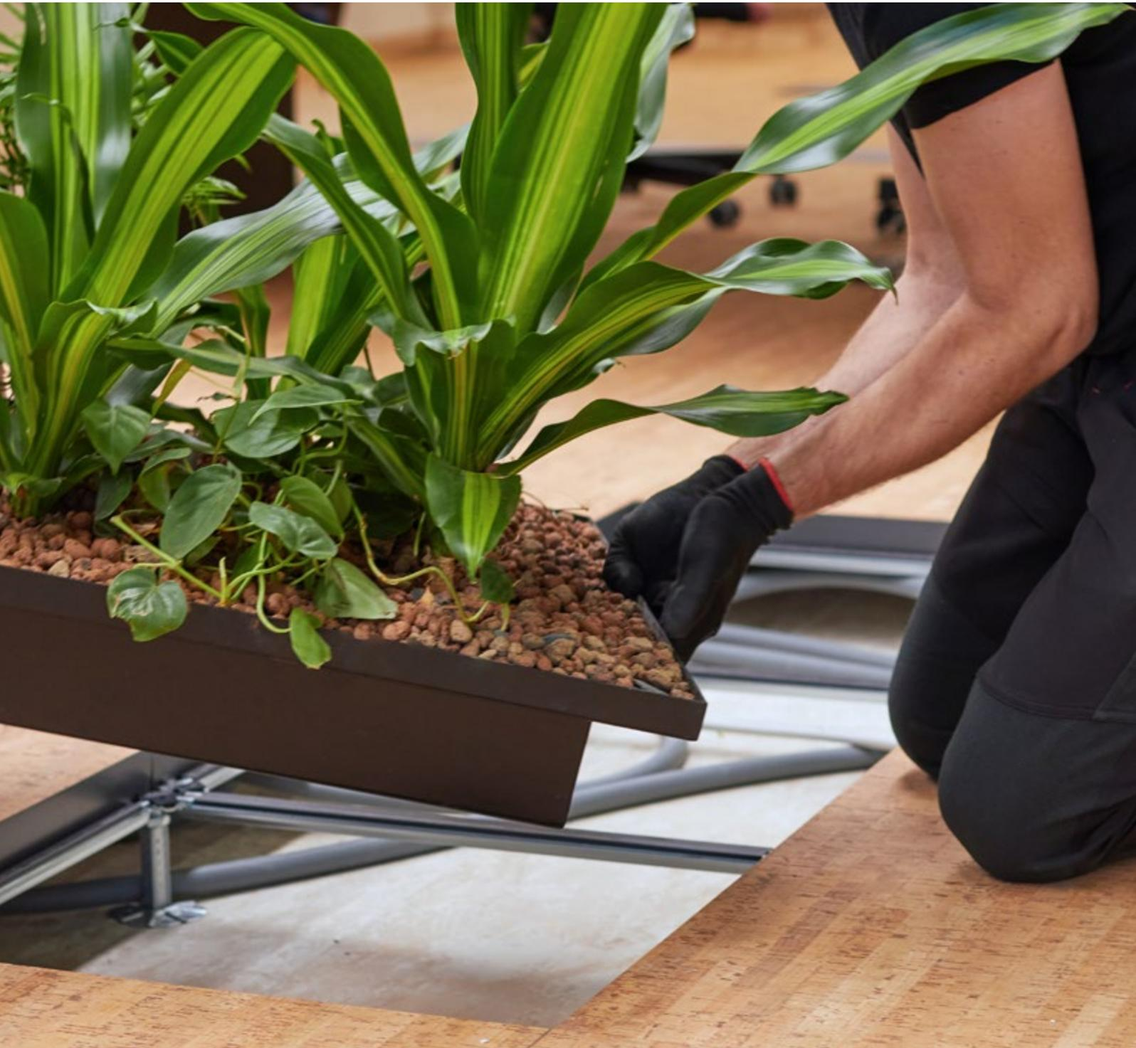
Floora è il **sistema flessibile di piante a pavimento**, intercambiabile con i pannelli del sopraelevato, anche preesistenti, che permette di progettare aree personalizzate di verde negli spazi indoor.
