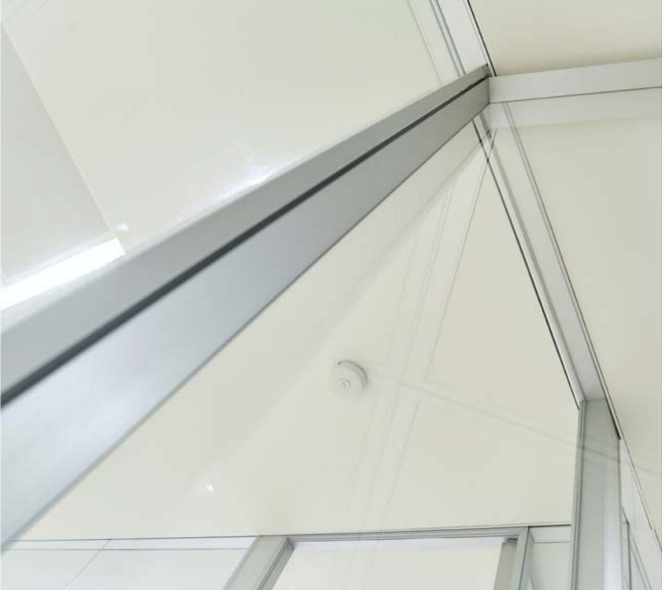
détail des cloisons vitrées intégrées dans le faux plafond
