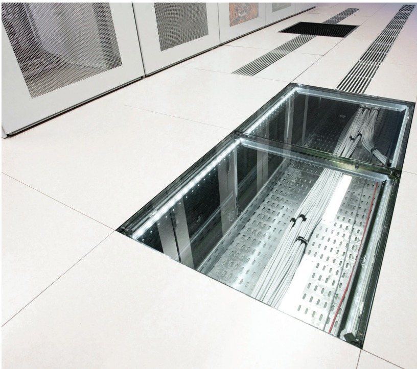
DETTAGLIO DI UN PAVIMENTO SOPRAELEVATO PER DATA CENTER
