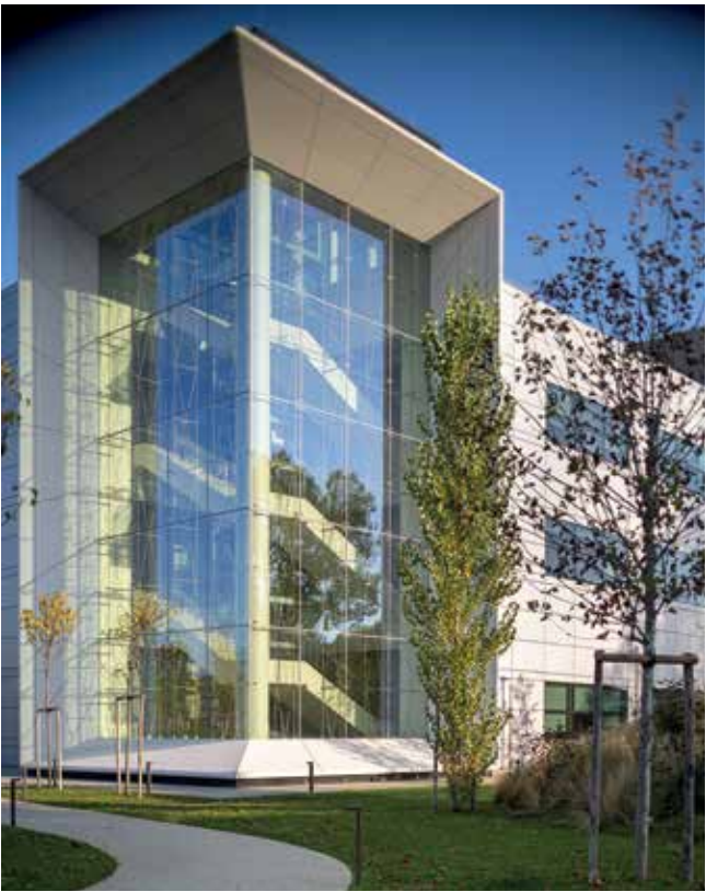
Come nella hall, all'interno della torre della scala a nord una scala sospesa con parapetto in vetro collega tutti i piani a uso uffici e la terrazza (ph. ©Marco Zanta).
