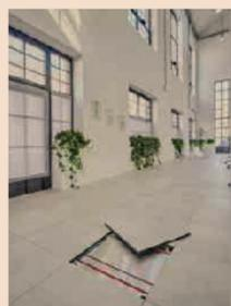
Pavimento sopraelevato radiante
