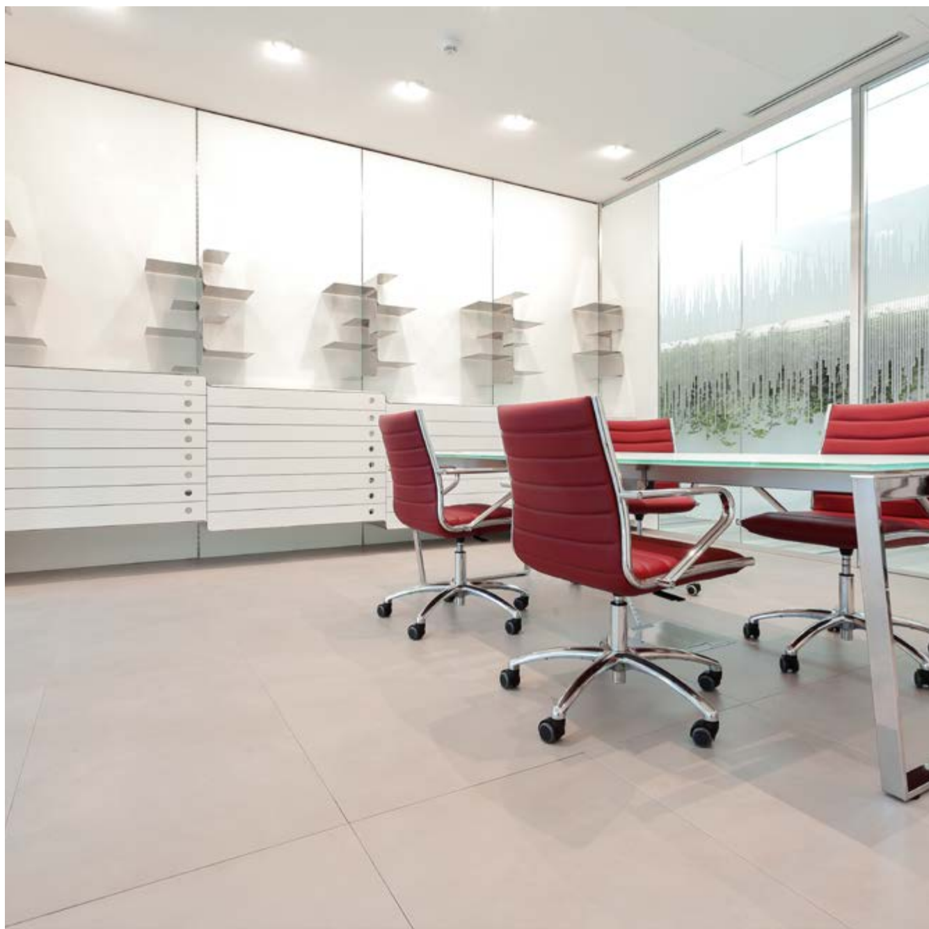
acabado: cerámica núcleo panel: sulfato cálcico dimensiones: 600x600 mm
