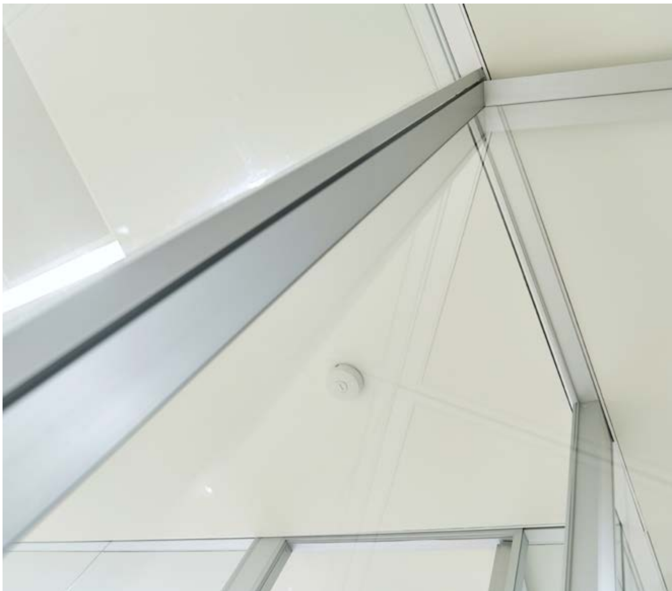
dettaglio partizioni in vetro integrate nel controsoffitto
