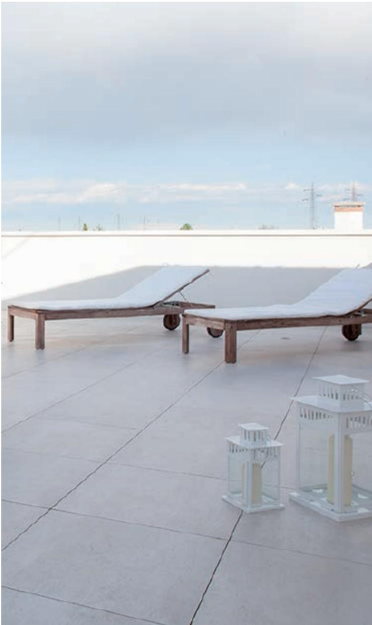
TWIN FLOOR es un panel de alta densidad ( $\text{Kg}/\text{m}^3$  2.200), realizado mediante un proceso particular de pegado del acabado superior en gres o en piedra a un soporte inferior compuesto de materiales inertes e inorgánicos, sinterizados a muy altas temperaturas.
