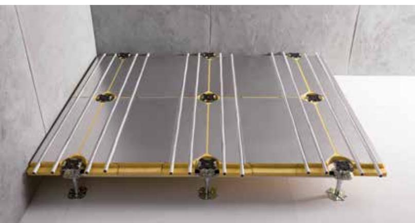
**6/** Posa dei pannelli di finitura curandone il corretto appoggio sulle quattro colonnine che li sostengono. Taglio e la posa dei traversi perimetrali e dei pannelli perimetrali a completamento del sistema.
