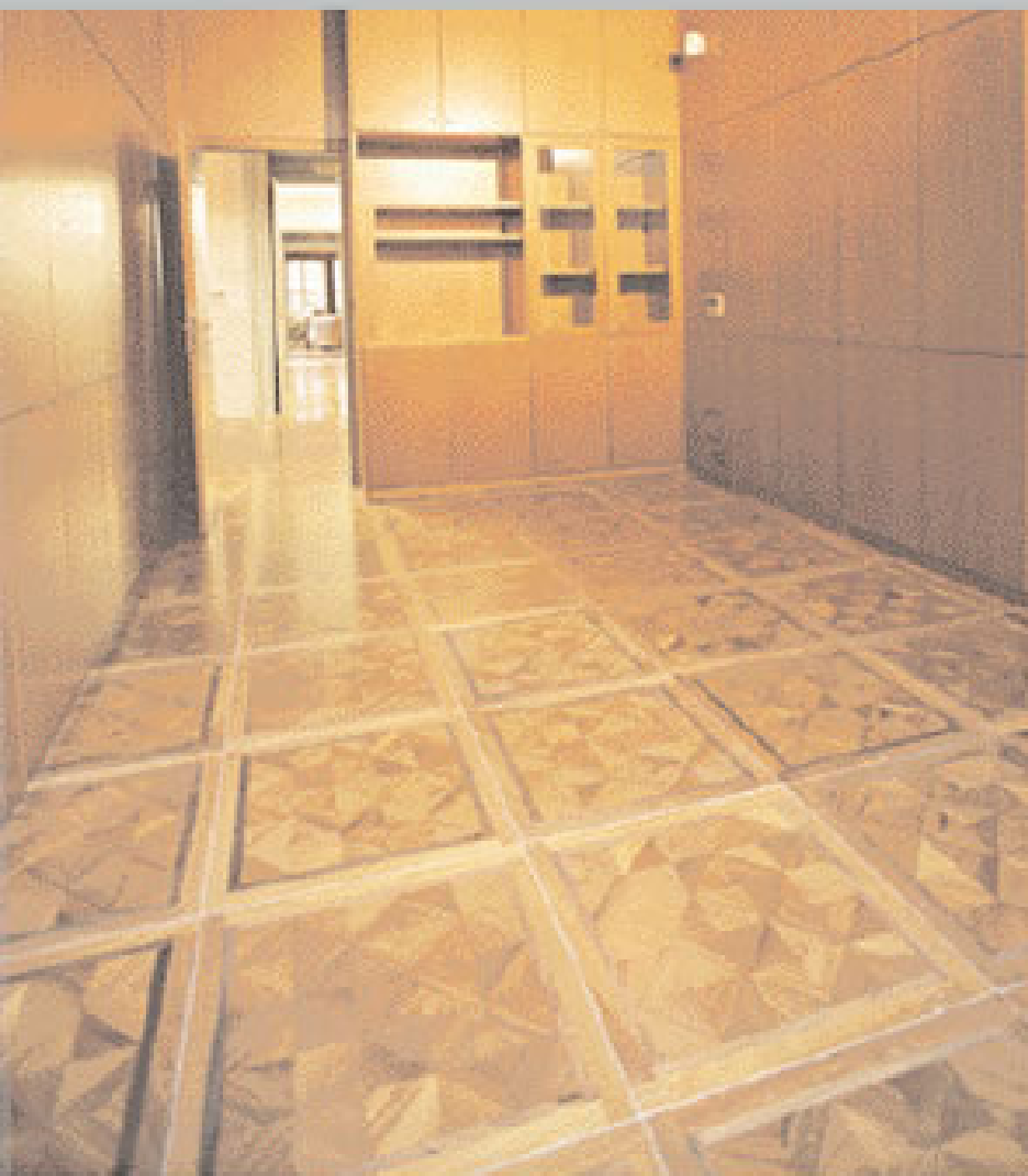
1 Pavimento Sopraelevato Nesite con eleganti pannelli di copertura in parquet 2 I pannelli del Sistema Pavimento Sopraelevato Nesite sono facilmente rimovibili per ispezioni o manutenzione
